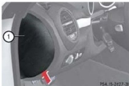
① Deckel Hauptsicherungskasten
